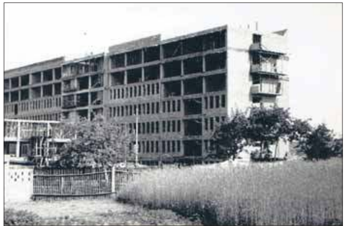
Budowa szpitala przy ul. Chełmońskiego
