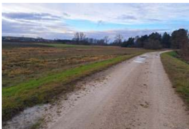
Wał przeciwpowodziowy wzdłuż prawego brzegu Nidy – na odcinku Brzeźno-Sobków, jest wykorzystywany również jako droga dojazdowa
