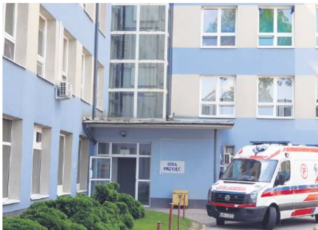
Na początku 2024 roku Izba Przyjęć i podjazd dla karettek będzie bardziej nowoczesny i dostosowany do potrzeb pacjentów i personelu medycznego.
