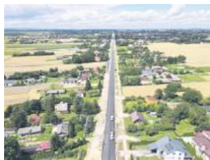
Po zakończeniu prac zwiększy się bezpieczeństwo w ruchu drogowym i poprawi komfort podróżowania.
