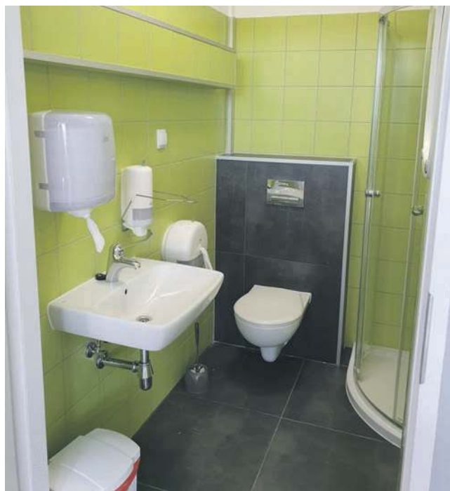
Tak wyglądają wyremontowane łazienki na oddziale wewnętrznym
