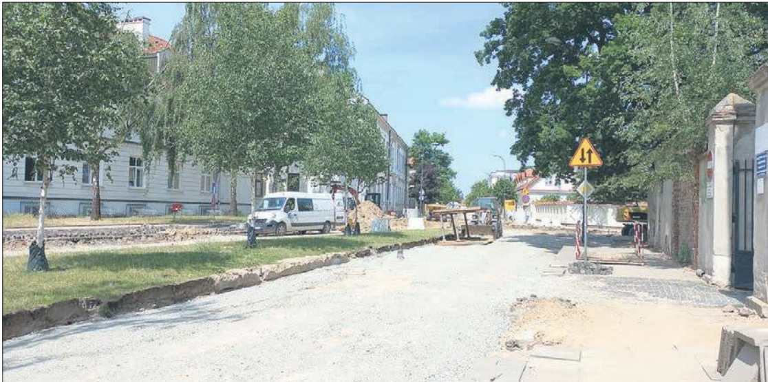
Prace u zbiegu ul. Kościuszki z pl. Dąbrowskiego i ul. Misjonarską
