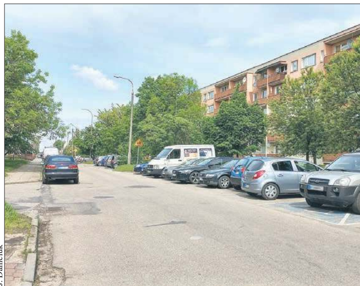
Przebudowa fragmentu ulicy Lasockiego potrwa 5 miesięcy
