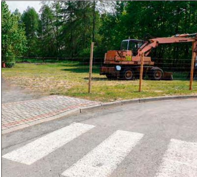
Przebudowa już się zaczęła.
