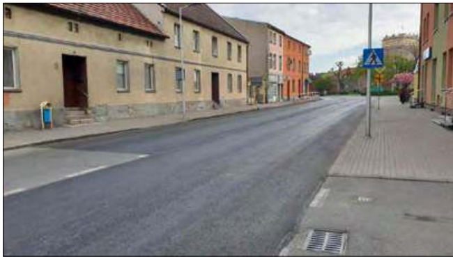
Pasy przy krapkowickim kinie zniknęły po remoncie.
