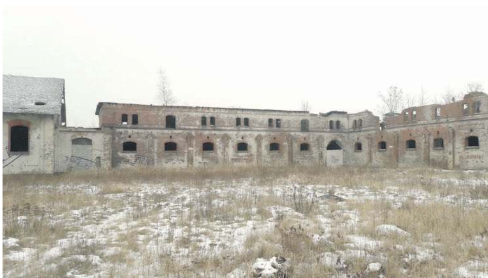
Tak było przed rozpoczęciem przebudowy
