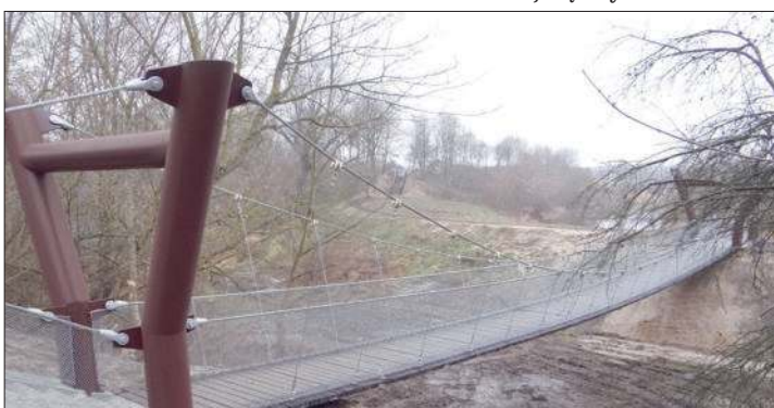
„Kraina suma” to również kładka wisząca na stalowych linach o długości ok. 40 m.
