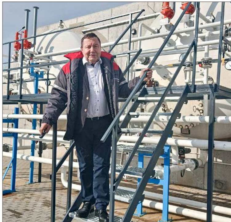
Stanisław Leski przy zbiornikach, które zwiększyły możliwości magazynowe Gas Trading Podkarpacie.
