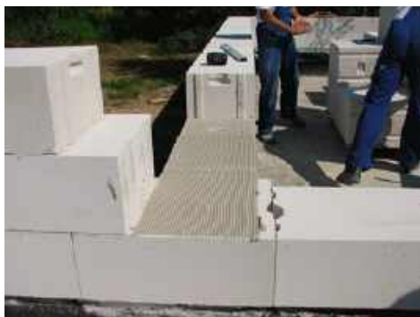
Elementy murowe w ścianach jednowarstwowych łączy się za pomocą tzw. cienkiej spoiny, której grubość nie przekracza 3 mm. SOLBET
