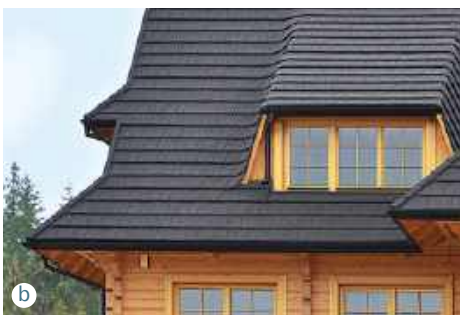
📍 Blachodachówka z powłoką poliestrową (a RUUKKI) i posypką mineralną przypominającą tutek kamienny (b AHI ROOFING).
