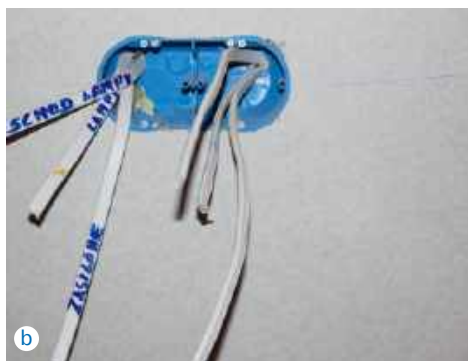
🔗 Inne puszkę instalacyjną stosuje się w murach pełnych (a), inne w ściankach z płyt gipsowo-kartonowych (b). J. WERNER
