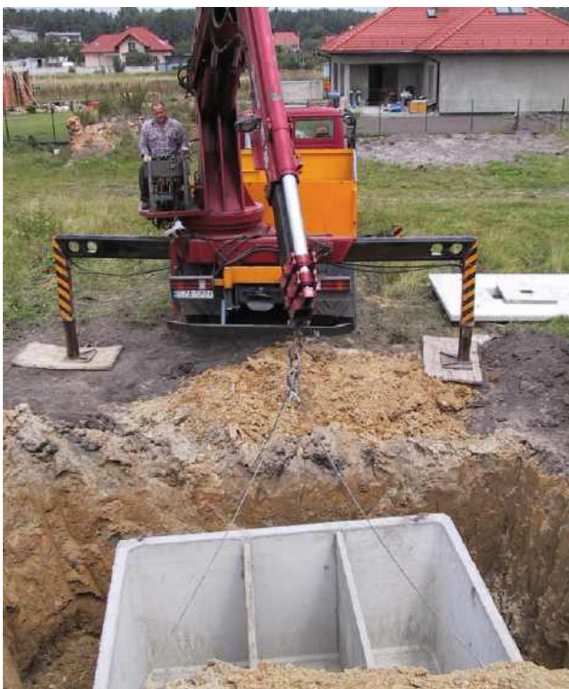
📍 Betonowy zbiornik szamba osadzany przy pomocy samochodowego dźwigu. PROBUD
