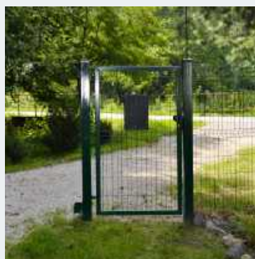
❶ Wszystkie elementy ogrodzenia wykonano z prefabrykowanych elementów z betonu i stali.
