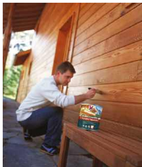
📌 Drewno jest modne i eleganckie, ale też wymagające, bo trzeba je regularnie zabezpieczać przed wilgocią, promieniowaniem UV i biologiczną degradacją. v33
