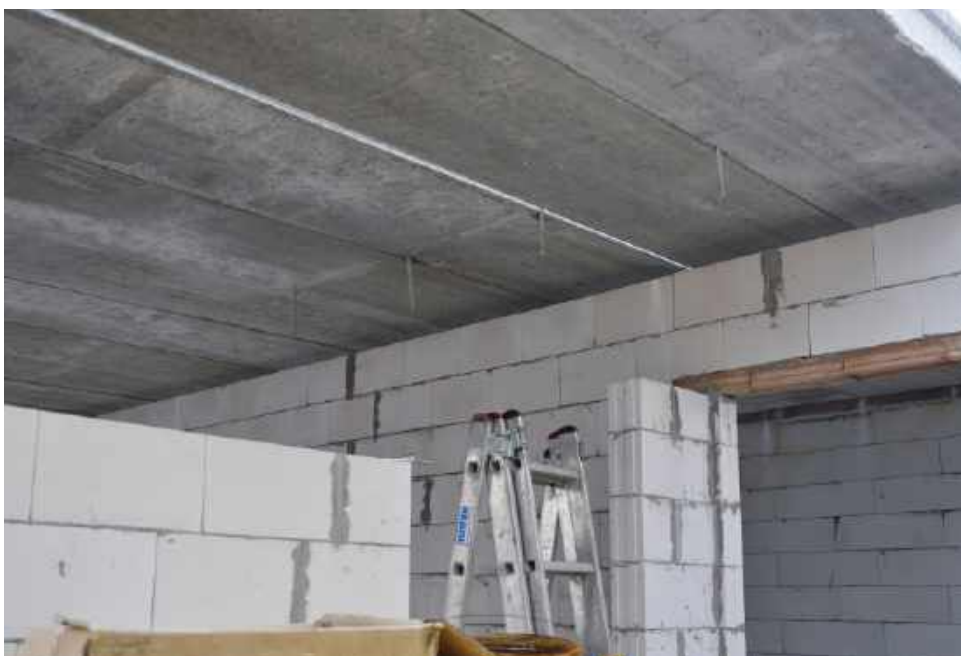
🔴 Stropy panelowe nie są narażone na klawiszowanie – nie uginają się pod obciążeniem pojedynczych elementów. STROPY.PL
