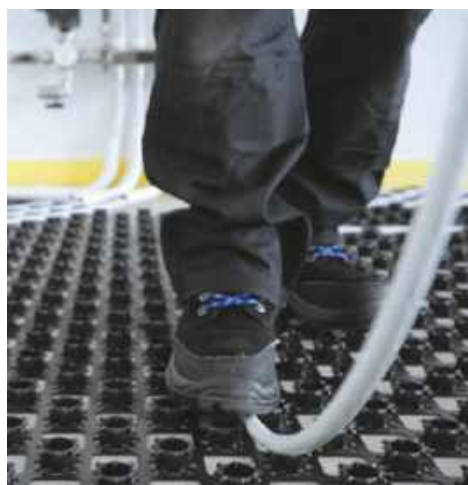
Zastosowanie płyt systemowych z wyprofilowanymi zagłębieniami na rurki grzewcze pozwala przyspieszyć prace montażowe. rwc
