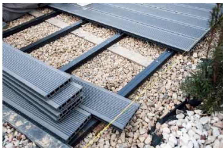
📍 Systemy tarasowe z drewna lub kompozytu są szybkie w montażu. Deski przytwierdza się do legarów rozmieszczonych co kilkadziesiąt centymetrów. JAF POLSKA, KOPP
