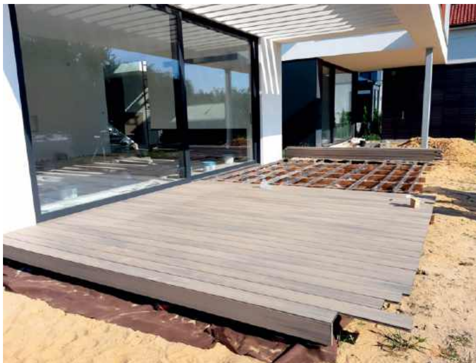
📍 Taras z desek należy montować na równym podłożu bądź punktowych podporach z bloczków fundamentowych. JAF POLSKA
