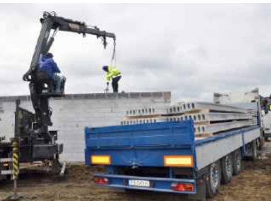
🔴 Prefabrykowany strop panelowy można ułożyć w dwie godziny, bez konieczności korzystania z ciężkiego dźwigu, wystarczy samochód z dźwigiem typu HDS. STROPY.PL
