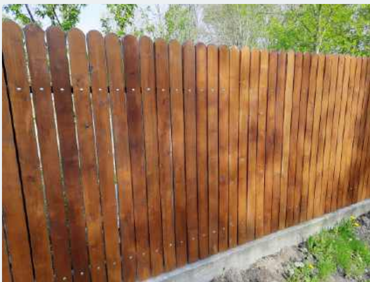
🔗 Sztachety przytwierdzono śrubami do płaskowników ze stali (poziomych). pasa.pl/9edcb101a4
