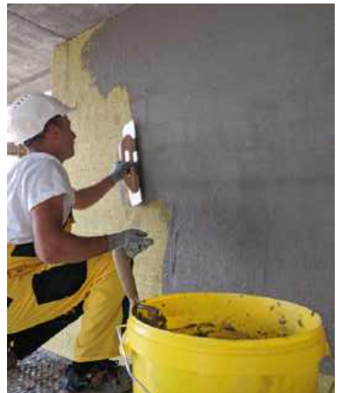
📍 Tynk cienkowarstwowy to podstawowy wybór w przypadku ścian dwuwarstwowych ocieplonych metodą lekką moką. ISOVER
