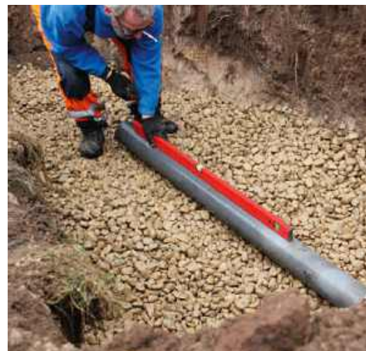
📍 Rury drenarskie układa się w grubej warstwie kruszywa, ze spadkiem umożliwiającym grawitacyjny spływ ścieków. J. WERNER
