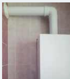
Przy kompaktowym kondensacyjnym modelu zastosowano system kominowy rura w rurze.
