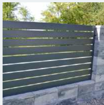
🔗 Ogrodzenie frontowe wykonano z kształtek betonowych i przęseł ze stali.
