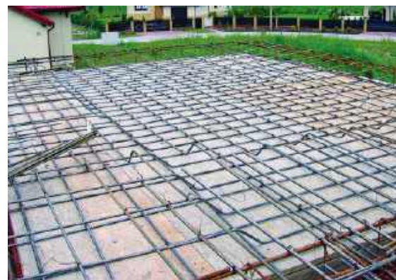
Budowa stropu żelbetowego wymaga ułożenia skomplikowanego zbrojenia. STALEXPORT
