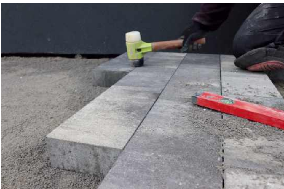
🔗 Nawierzchnie utwardzone: opaskę, chodnik, taras zawsze układa się ze spadkiem od budynku. LIBET
