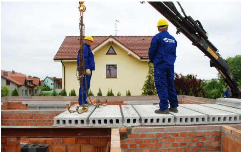
🔴 Panele stropowe są węższe i lżejsze od płyt kanałowych. STROPY.PL
