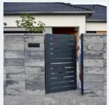
🔗 W murek przy furtce (1 m) wbudowano listownik, wideodomofon.
