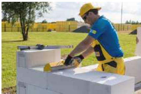
Zaprawę cienkowarstwową i klej poliuretanowy w postaci pianki nakłada się precyzyjnie za pomocą specjalnej pacy lub aplikatora. Cienka warstwa spoiny gwarantuje, że ściana będzie pozbawiona liniowych mostków cieplnych. YTONG (XELLA)
