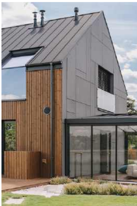
📌 Oblicówkę z drewna mocuje się do rusztu przytwierzonego do ściany. JAF POLSKA
