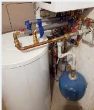
🔧 W nowej instalacji, wykorzystano m.in. istniejące sprawne naczynie wzbiorcze.
