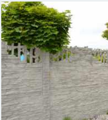
Faktura paneli imituje łupany granit, ale została wytoczona w betonie.
