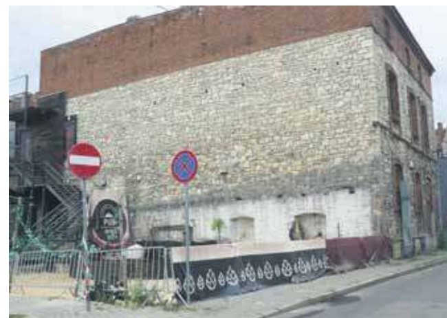
Po wyburzeniu dawnego sklepu widać dwie wnęki w bocznej elewacji dawnego magazynu win Sedlaczka
