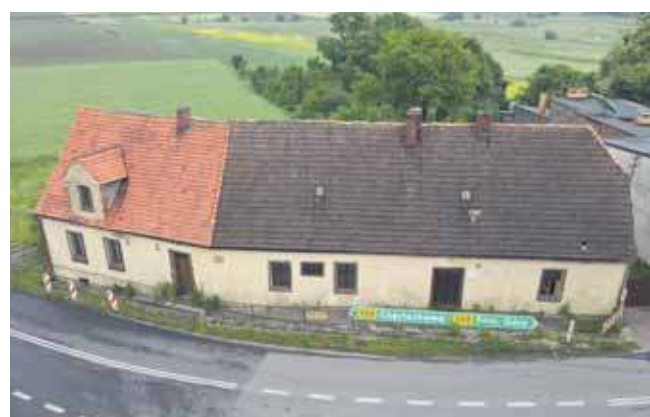
Budynek dawnej szkoły, w której uczył Józef Lompa. Niestety budowla jest w złym stanie
