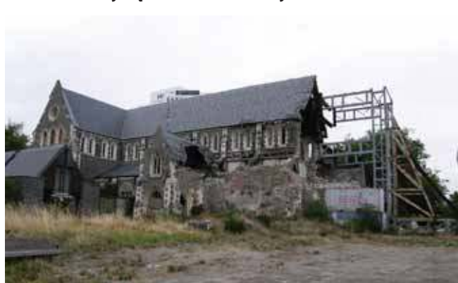
Zniszczona przez trzęsienie ziemi katedra w Christchurch
