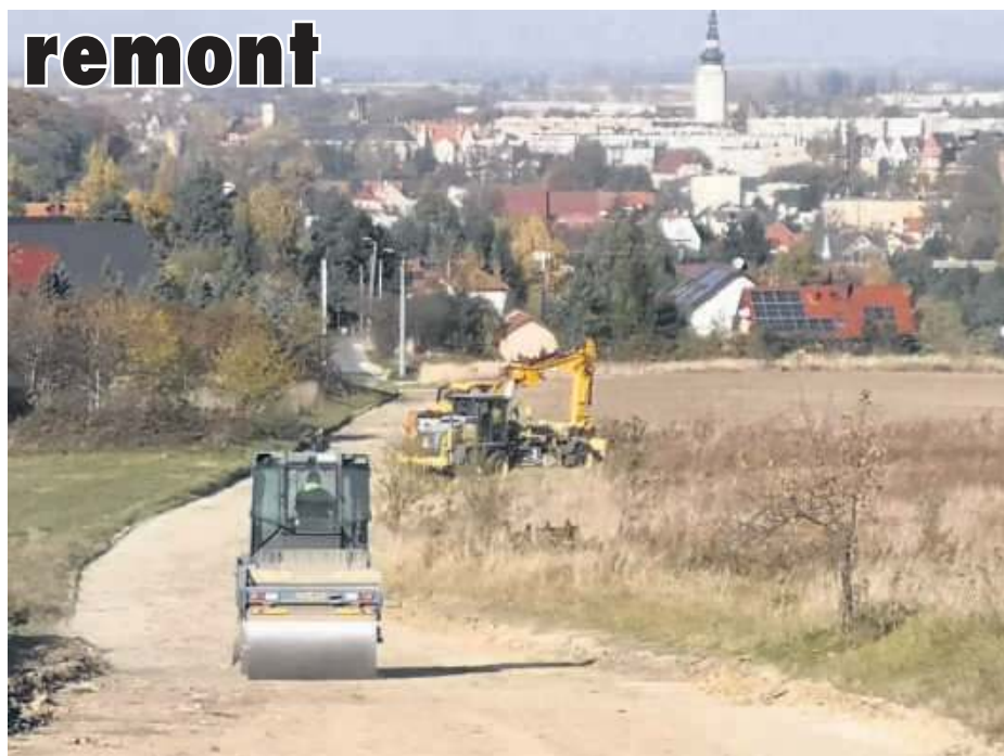
Od kilku dni trwają prace remontowe na ul. Sosnowej w Gęsińcu. Na początku skalno-ziemna droga została wyrównana i ubita walcem
