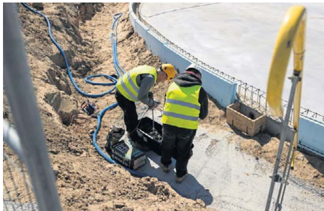
Początek budowy biogazowni spółki ProNatura - kwiecień 2026 roku
