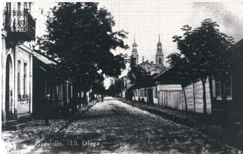
Ulica Długa w Garwolinie na początku XX wieku. Wybrukowana na przełomie XIX i XX stulecia, z rynszto- kami i chodnikami dla pieszych (Domena publiczna)
