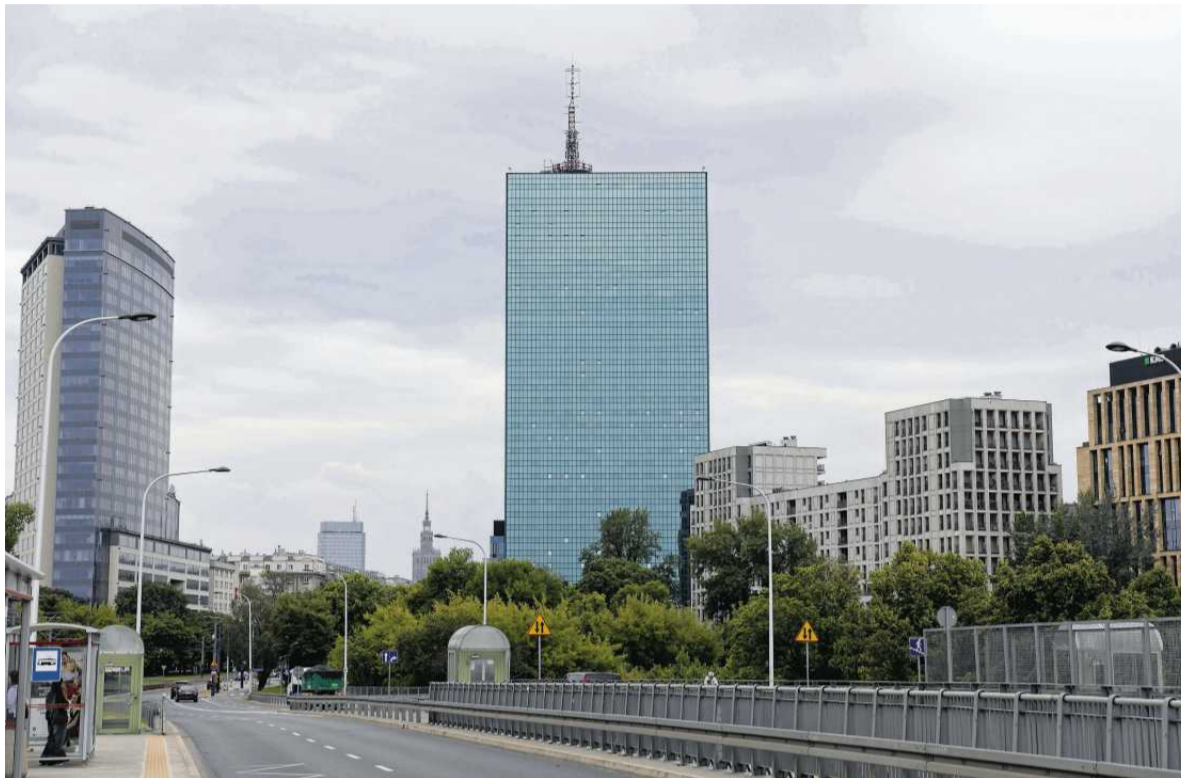
• Wieżowiec Intraco przy ul. Stawki 2. FOT. DAWID ŻUCHOWICZ / AGENCJA WYBORCZA.PL
