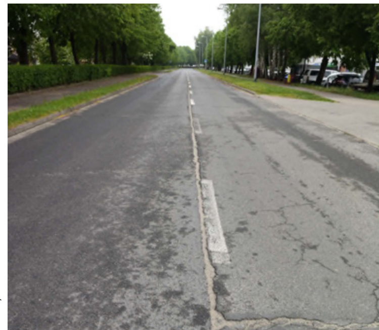
Czas na modernizację.
