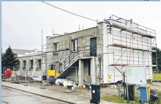
1. Trwa przebudowa wraz z termomodernizacją budynku świetlicy w Stanowicach
