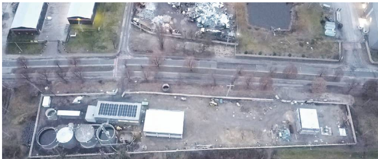
Na takim etapie była budowa oczyszczalni ścieków firmy Jack-Pol na początku stycznia 2022 roku
