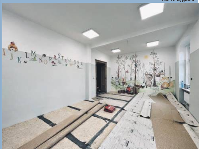
4. Remont Niepublicznego Zespołu Wychowania Przedszkolnego w Oleśnicy Małej
