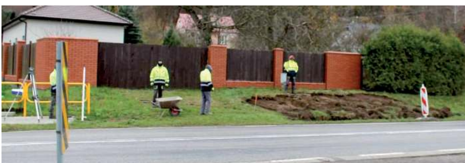
Od kilkunastu dni trwają prace nad chodnikiem w Parchatce, który będzie wydłużony o kolejne 400 metrów. Inwestycję wykonuje firma z Bełżyc
