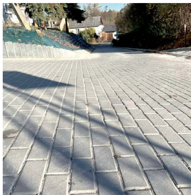
A tak teraz wygląda droga dojazdowa do urzędu. Zamiast asfaltu jest kostka brukowa
