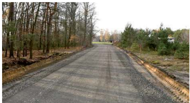
Droga w Kochanowie będzie miała inną nawierzchnię. Wkrótce mieszkańcy do swoich posesji będą dojeżdżać po asfalcie
