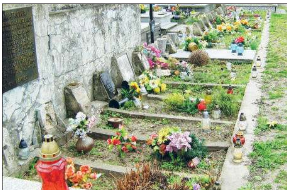
Z mogiły odpadają tynk i cegły, brakuje tabliczek z nazwiskami pomordowanych.
