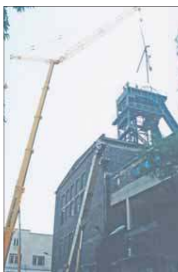
10 lipca, po 44 latach górowania nad miastem, rozpoczęto rozbiórkę szybu „Kościuszkowski” KWK Jaworzno
