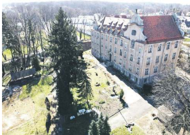
Nie widać szans na zagospodarowanie budynku
