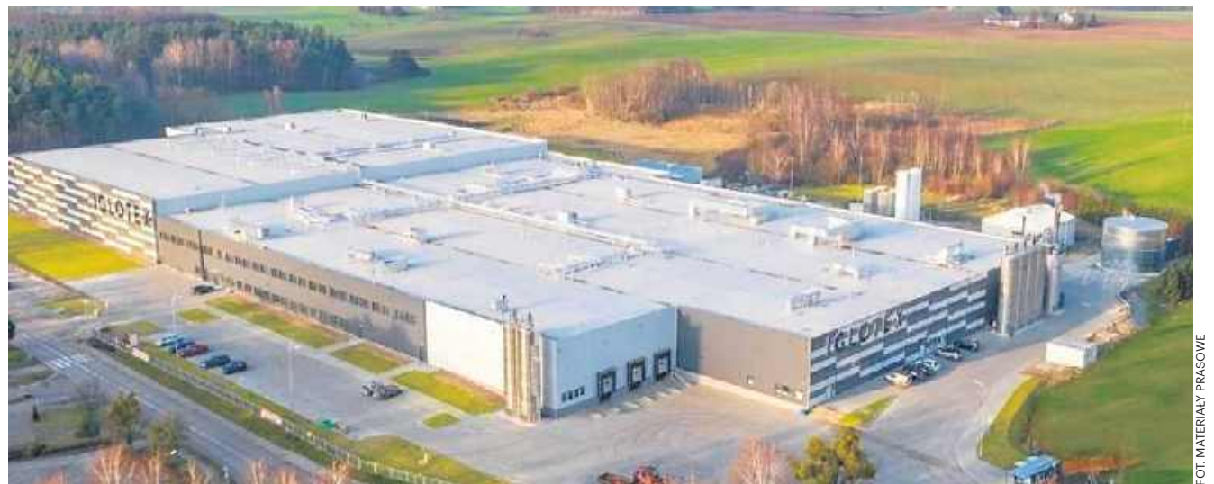
Zakład produkcyjny firmy Iglotex w Skórczu doczeka się rozbudowy i modernizacji
