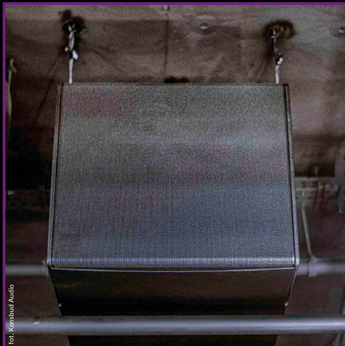
Wydajny, centralnie zainstalowany subwoofer o charakterystyce kardoidalnej odpowiada za dystrybucję dźwięku o najniższych częstotliwościach.
