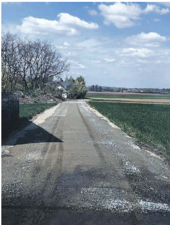
Remont drogi gminnej w miejscowości Budzicz
