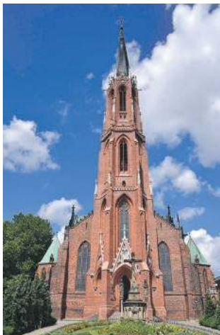
Kościół pw. Najświętszej Maryi Panny w Bielawie. Na jego wieży znajduje się taras widokowy
