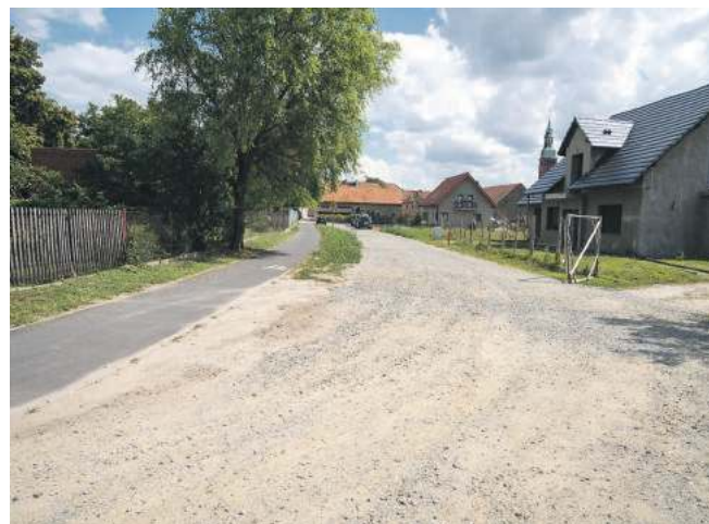
Na ul. Spacerowej w Prusicach została wykonana stabilizacja podłoża przez Prusickie Drogi Spółka z o.o.
