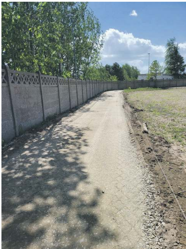
Remont drogi gminnej na bocznej ul. Polnej w Prusicach
