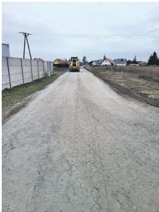
Remont drogi gminnej ul. Pietrowickiej w Prusicach
