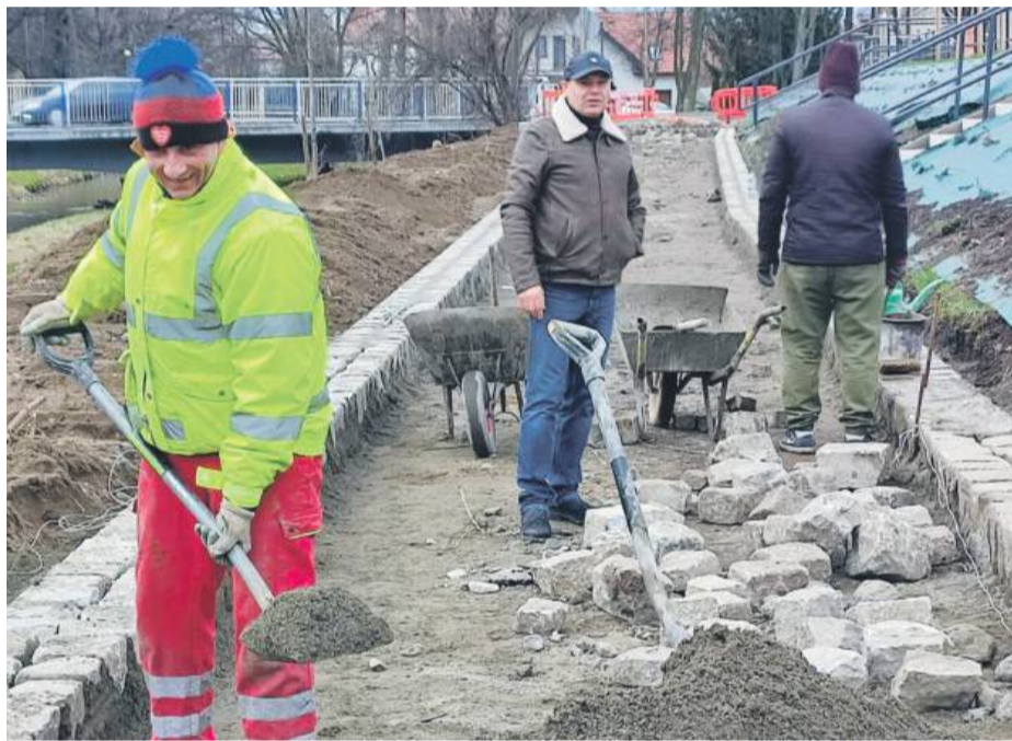
Rajmund Czernik (w środku), właściciel firmy budującej drogę przy skateparku wyjaśnia szczegóły techniczne prowadzonej inwestycji. Z lewej widoczny wał przeciwpowodziowy, który finalnie zostanie podniesiony o 30 cm
