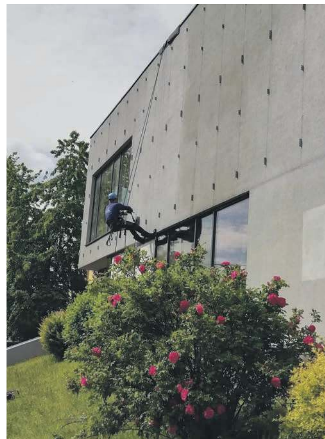
Wykonywane przez Silver-Service roboty wysokościowe
