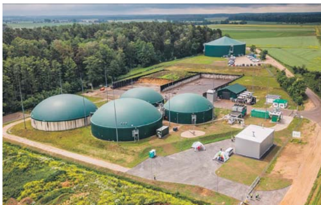
Biogazownia w Dzierżkach
