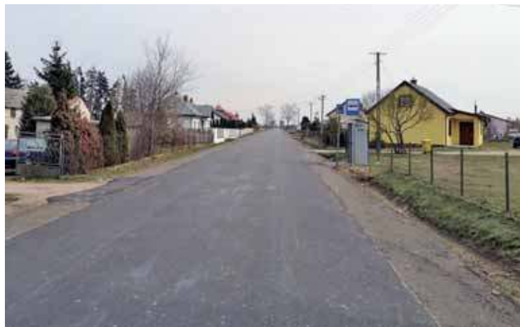
Fragment zmodernizowanej drogi
