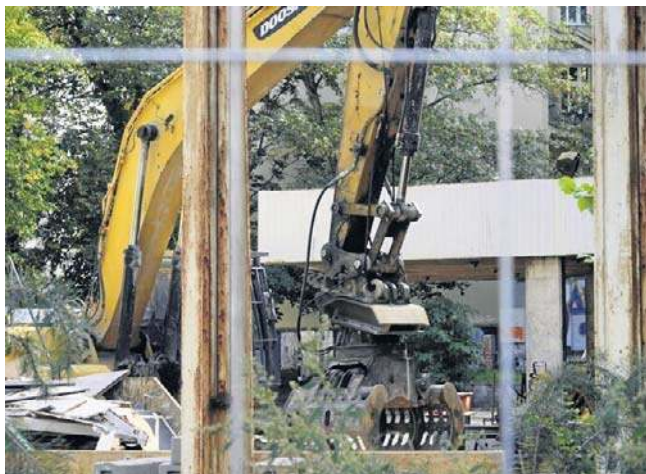
Prace rozbiórkowe na terenie dawnego kina Olimpia
