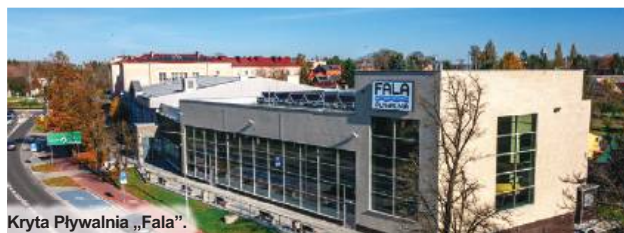
Kryta Pływalnia „Fala”.
