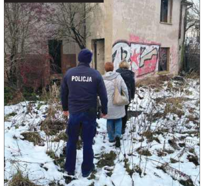
■ Policja z urzędnikami sprawdza opuszczone budynki
