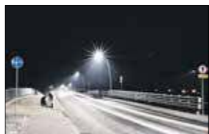
Wprawdzie nowym mostem, będącym alternatywną trasą przeprawy przez dzielącą miasto na dwie części rzekę, można już jeździć od kilku dni, jednak uroczyste otwarcie zrealizowanej inwestycji zaplanowano na 30 grudnia
