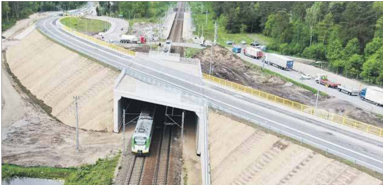
W budżecie zapisano 200 tys. zł na początkowy etap budowy wiaduktu
