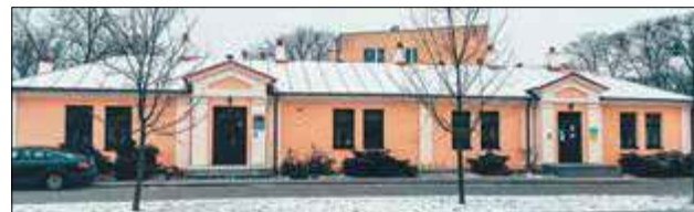
Od 2002 roku pawilon stanowi siedzibę tygodnika Słowo Podlasia, został wyremontowany, wnętrza zaadaptowane na potrzeby redakcji
