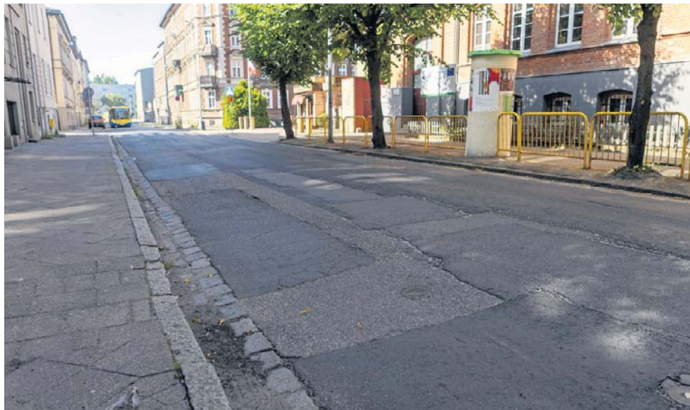
Planowane modernizacja ul. Henryka Pobożnego obejmie nie tylko całkowitą wymianę nawierzchni jezdni, ale też przebudowę chodników
