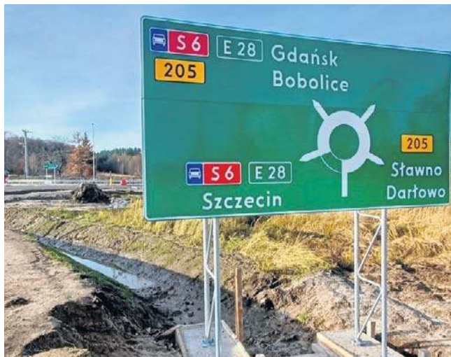
Przez całą S6 przejedziemy w połowie przyszłego roku, a na razie oddawane są do użytku kolejne jej odcinki
