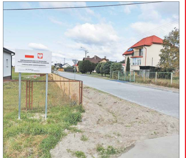
Wiosną bieżącego roku zakończono projekt pn. „Budowa i przebudowa dróg w miejscowości Sławatycze”
