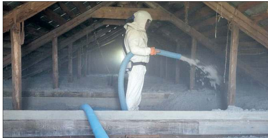
Fachowcy z Dragon Pur jako pierwsi w regionie wprowadzili innowacyjną, jak na tamte czasy, natryskową metodę ociepleń pianą PUR
