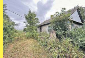
Działki budowlane w miejscowości Tchórzew, 885 851 158
