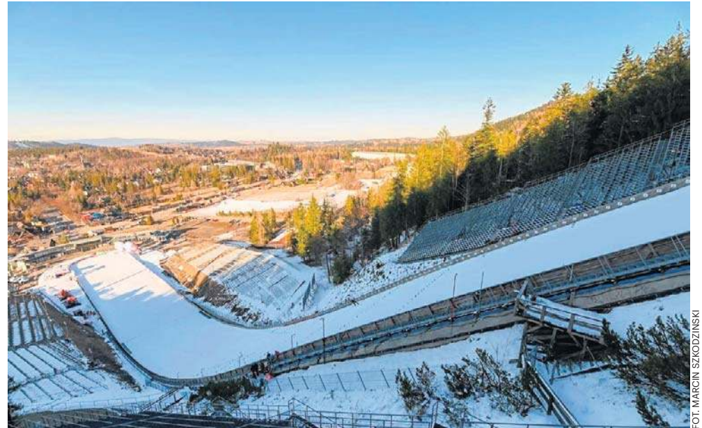
Wielka Krokiew w Zakopanem. W planach był demontaż 17-letniego już wyciągu narciarskiego i budowa nowego. Wszystko wskazuje na to, że nic z tego nie będzie
