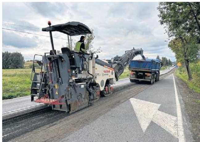
Planowany termin zakończenia remontu to koniec grudnia 2025 r.
