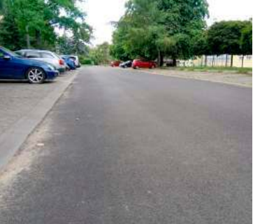
Nowy asfalt na ul. Poturzyńskiej
