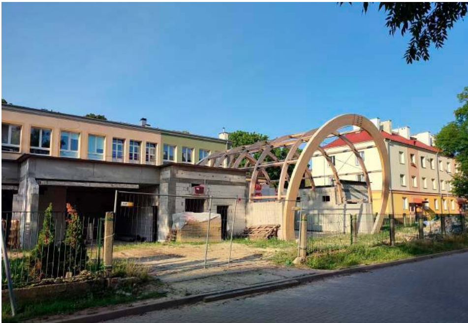
Na dokończenie rozbudowy SOSW w tym roku, przy obecnym stanie zaawansowania robót, nie ma już szans
