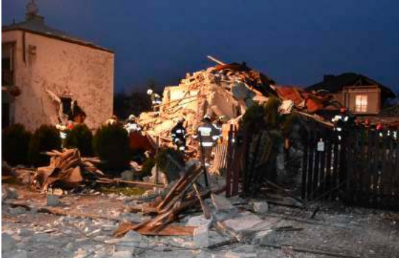
Z domu, w którym zatrzymana spowodowała wybuch gazu pozostała kupa gruzu
