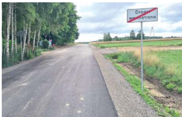
Droga gminna w Borysowie jest już oddana do użytku
