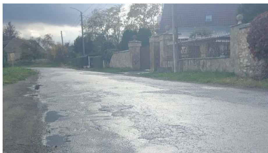
Może już w przyszłym roku czeka nas przebudowa drogi w Gościęcicach Dolnych
