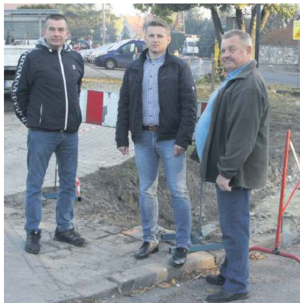
W ubiegły piątek postępowi prac przyglądali się Zdzisław Ziąber, dyrektor PZD (po środku) i radny powiatowy Ludwik Hrycak (po prawej). Na zdjęciu po lewej wykonawca inwestycji Waldemar Ginter
