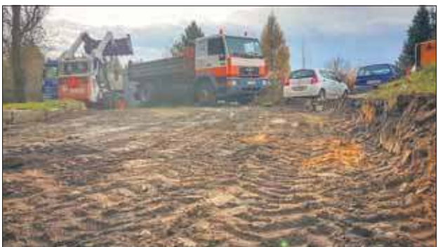
Prace nie powinny potrwać długo
