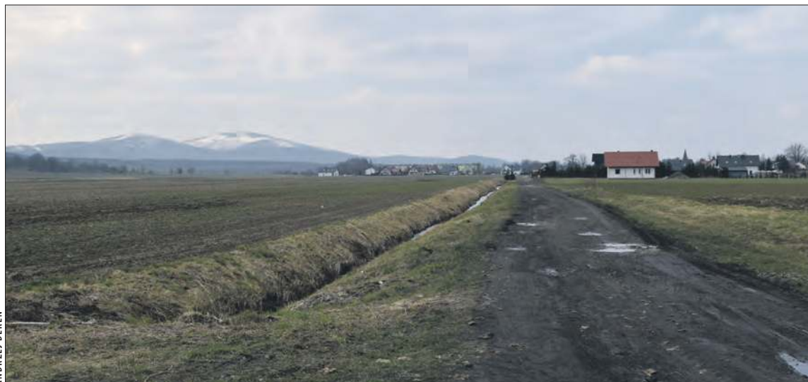
W zamierzeniach lokalnego samorządu jest modernizacja gminnej drogi z Łąki do Prudnika
