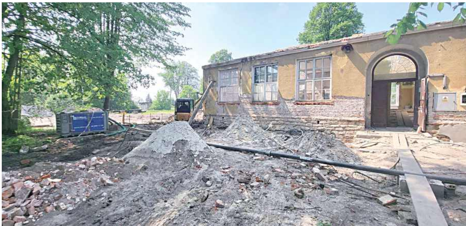
Tak wyglądał budynek w trakcie prac
