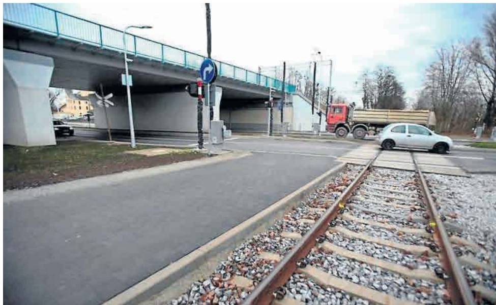
Widoczne na zdjęciu tory kolejowe utrudniają poprowadzenie trasy tramwajowej pod wiaduktem. Czy tory te zostaną przeniesione na wiadukt?
