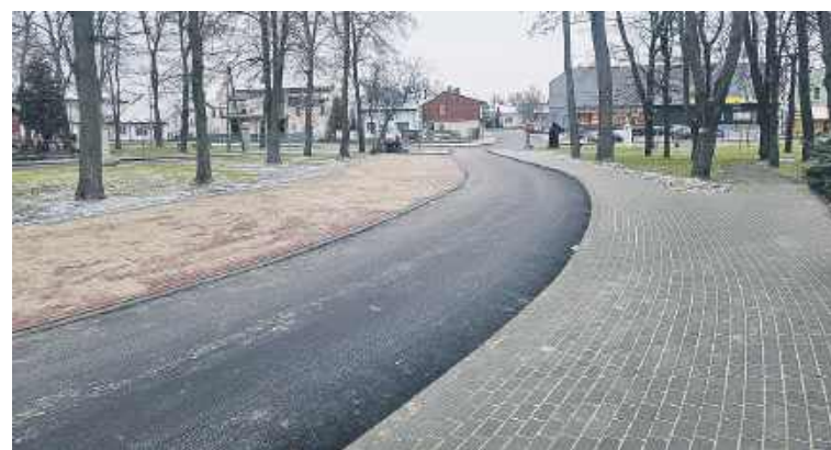
Wyremontowana ulica Kościelna w Siedliszczu
