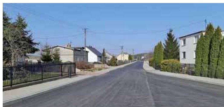
Nowa nawierzchnia asfaltowa i chodniki
