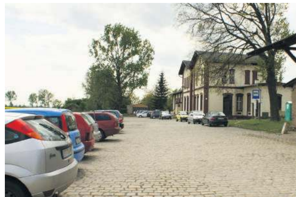
Na drodze przed stacją kolejową w Boreczku powstaną miejsca parkingowe i chodnik
