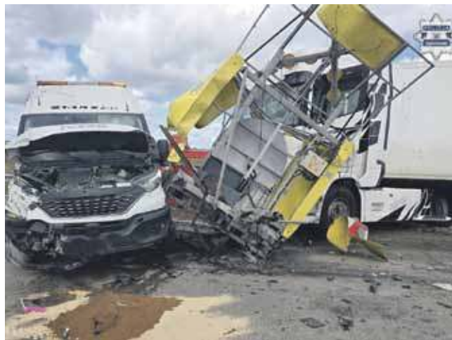
Kierowca Scanii wjechał w pojazdy należące do ekipy remontującej autostradę.
