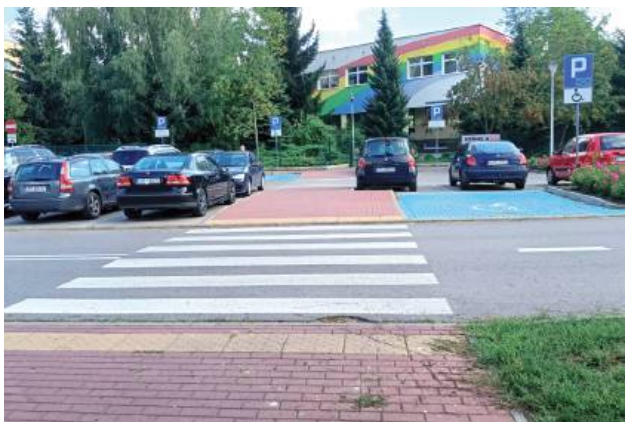
Zdaniem radnego to właśnie w tym miejscu przydałoby się wyniesione przejście dla pieszych. Innego zdania są jednak urzędnicy
