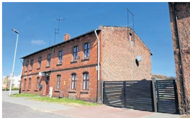
Lokatorzy kamienicy przy Szosie Chełmińskiej 110 zostali wykwaterowani
